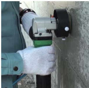
ハンディ式研磨機による表面研磨後、 水洗浄および乾燥
